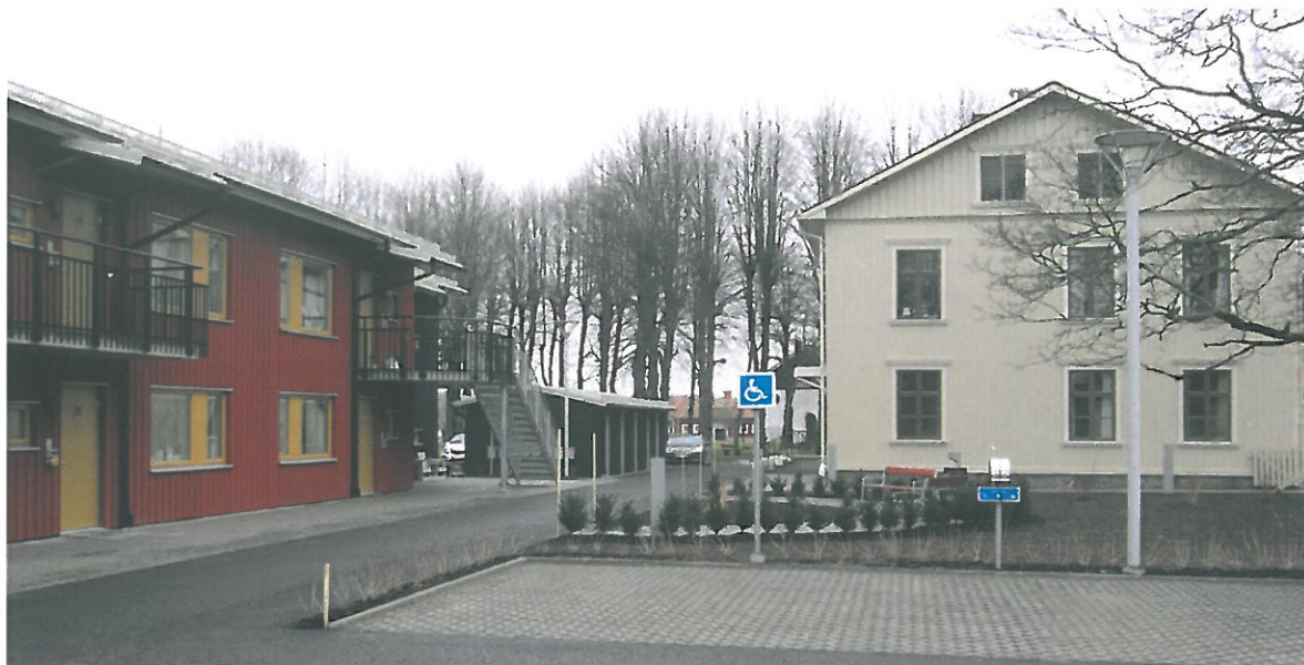
Ny- och ombyggnad Kronan Större 5
