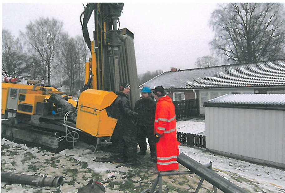
Borning för bergvärme i Fengersfors
