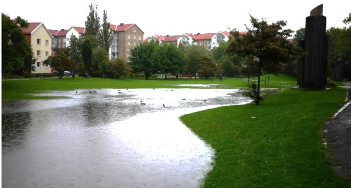
Figur 13. Exempel på avsänkt grönyta som tillåts översvämmas vid stora regn. Fotot är taget i Malmö av Daniel skog.
