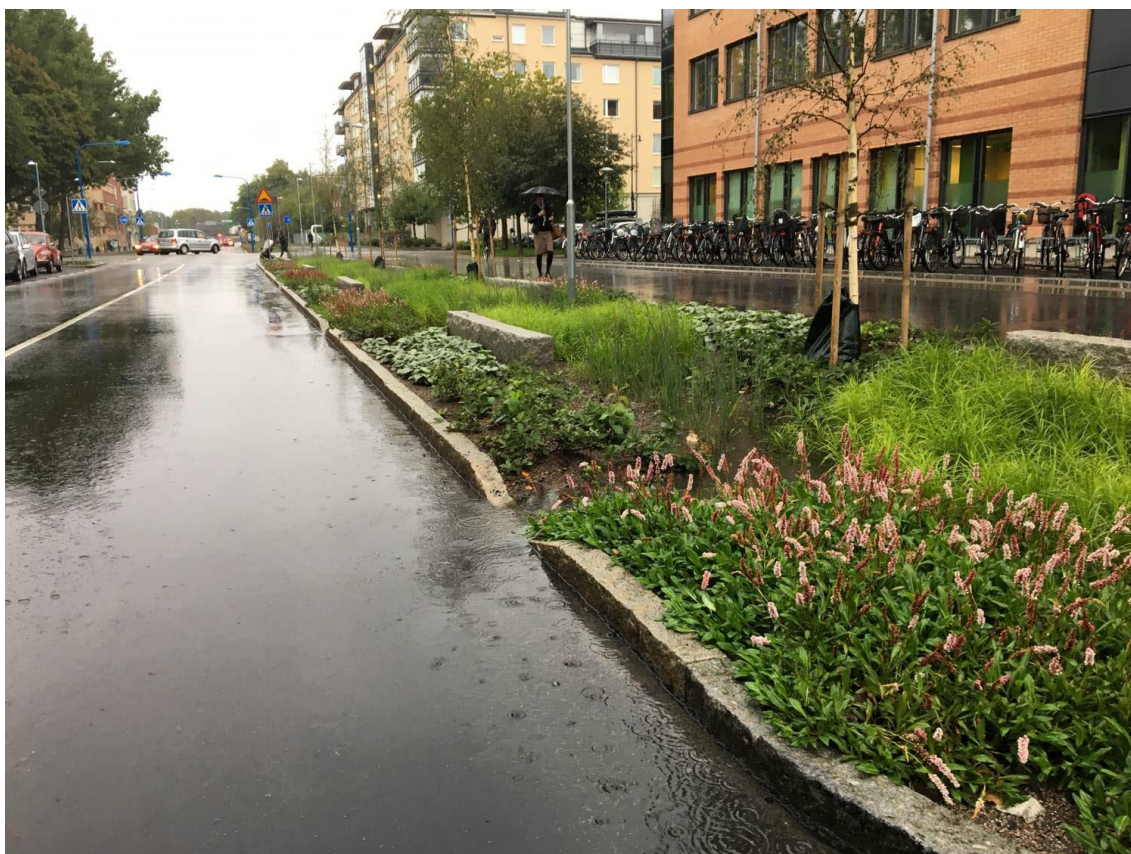
Figur 25. Biofilter i Uppsala. Foto: Kent Fridell, 2019.
