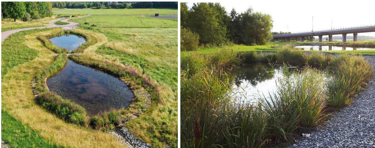
Figur 18. Exempel på dagvattendammar. (Foto: Vegtech AB).
