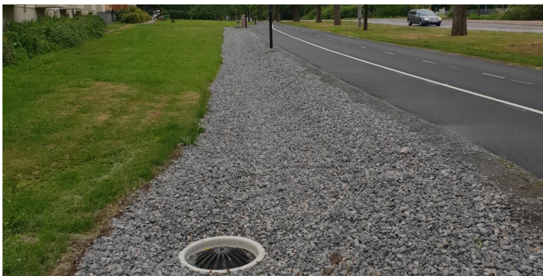
Figur 28. Exempelbild på ett makadamdike utmed en cykelväg. Foto: Dämmningsverket 2018.
