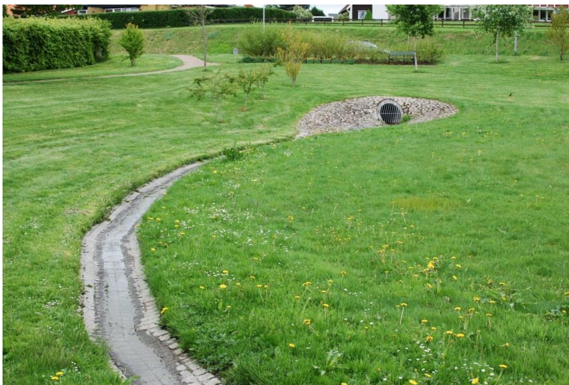
Figur 29. Exempel på en torrdamm / översvämningssyta. Foto: Sweco, okänt årtal.
