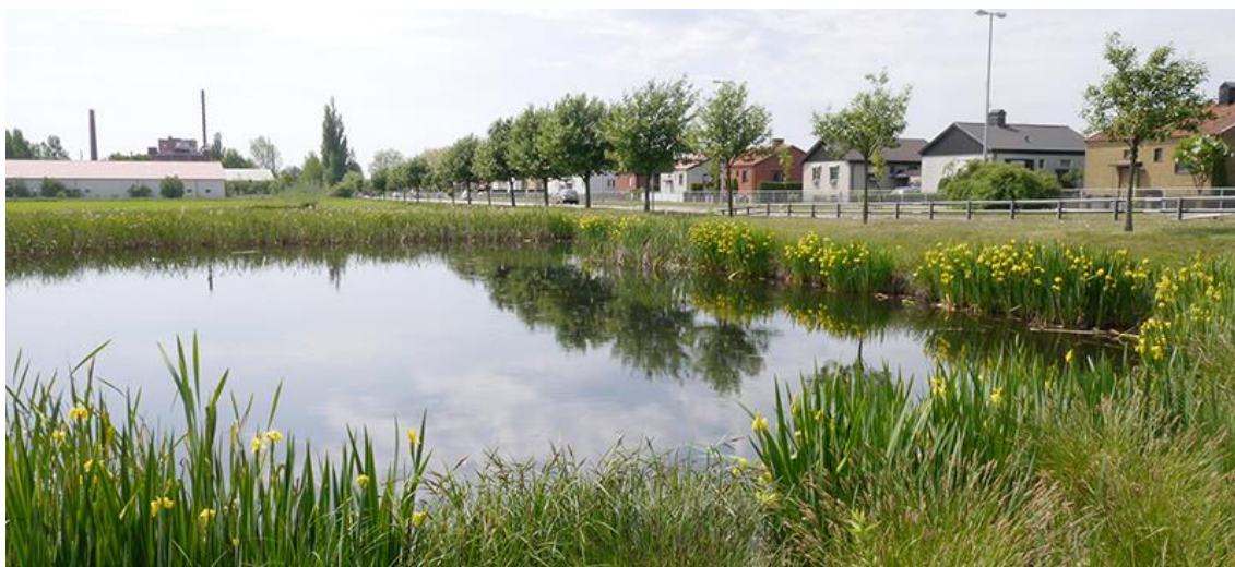
Figur 30. Dagvattendamm i Landskrona. Foto: NSVA 2018
