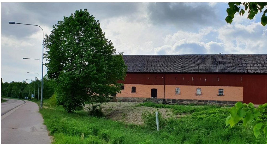
Figur 10 - Kulturhistoriskt värdefull ladugård sedd från Strömstadsvägen
