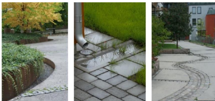
Figur 16. Exempel på utformning av dagvattenrännor i urban miljö. (Det högra och vänstra exemplet är foton från Sweco, exemplet i mitten kommer från S:t Eriks rännalsplattor)
